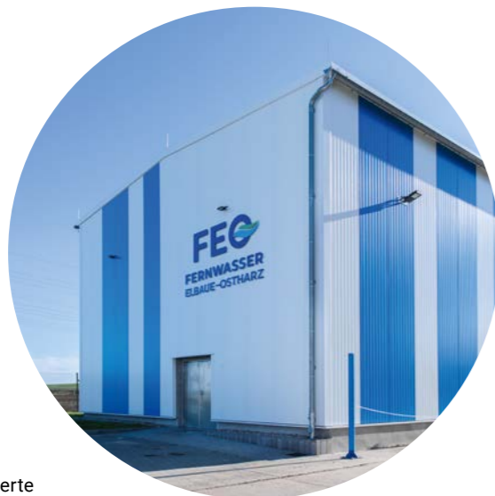
Die sanierte Abgabestation in Bernburg.
