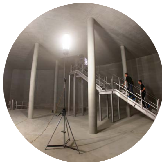
Das Innere der Wasserkammer bei der Besichtigung
